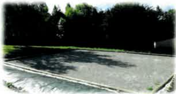
Finalisation du terrain de pétanque
