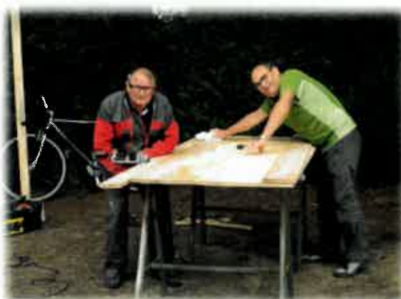
Réfection de la porte du lavoir
